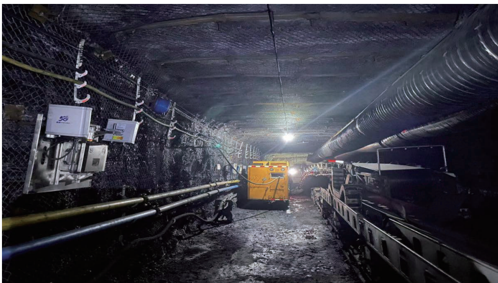
图 3-10 掘进工作面 5G 基站现场安装图
