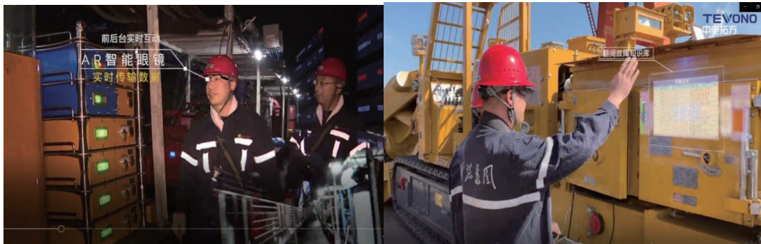
图 1-7 5G+AR 巡检与远程诊断系统现场应用
