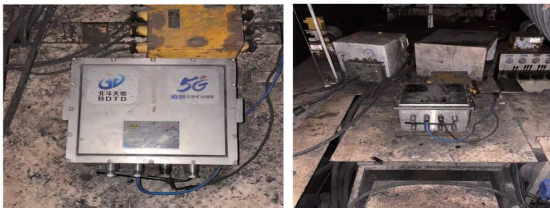
图 3-11 惯导系统装置现场安装图
