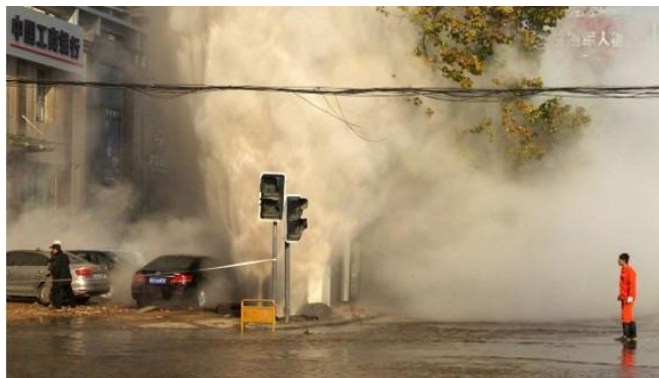
图 13 供热应急救援现场
