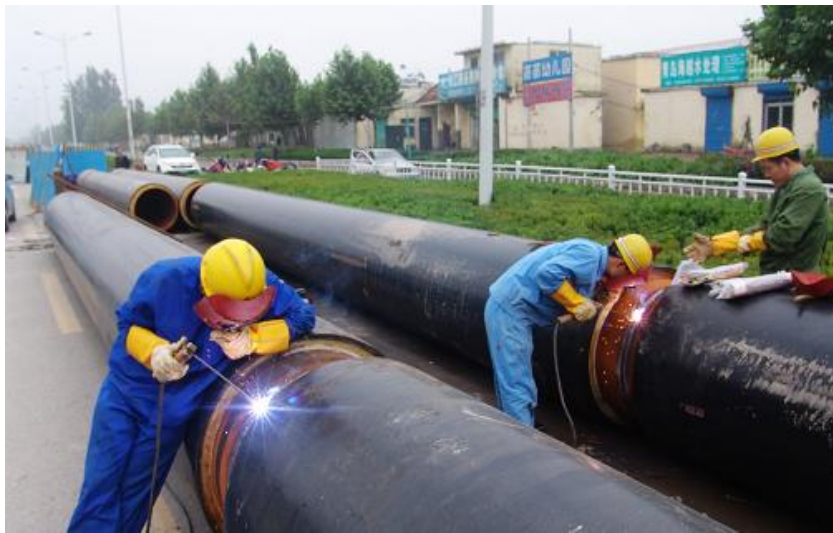
图 2 燃气管网施工现场
