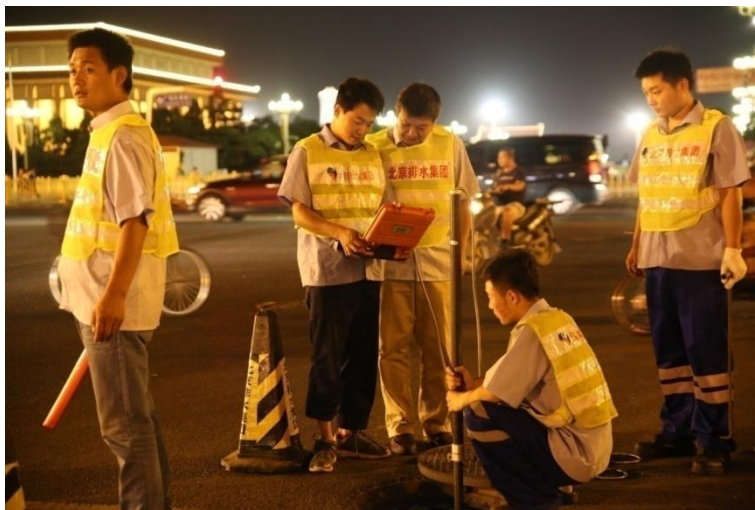
图 14 排水管线巡检
