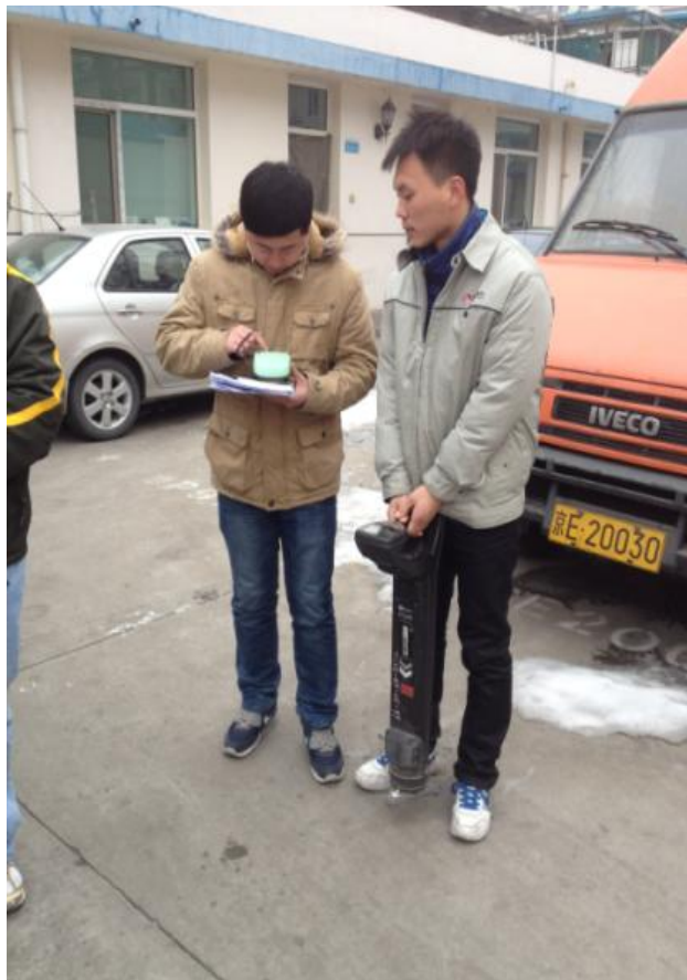
图 5 燃气精准防腐层探测
